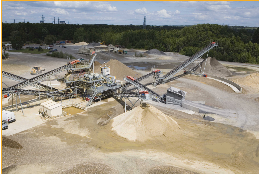
Les installations du site de La Frette : un exemple d'outil industriel de dernière génération. [Photo M. DELETANG]
